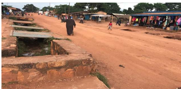
Voirie et drainage à Bambari
