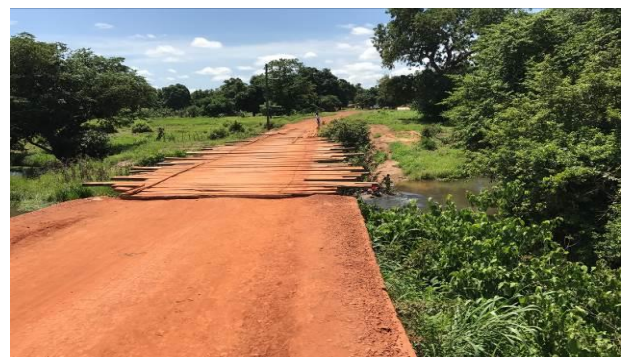
Ponceau de fortune, en bois défectueux à Kaga-Bandoro Source : Mbakhane Fall, juin 2017
