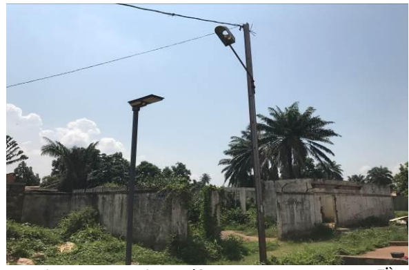
Eclairage public défectueux dans le 5 ème Arrondissement
